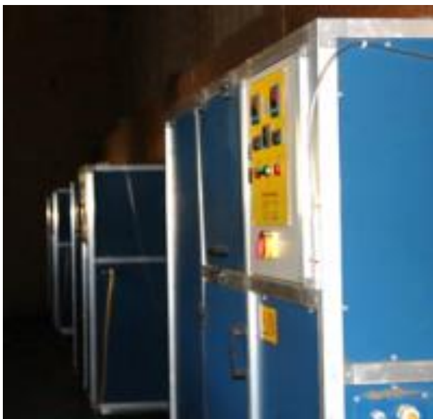
Figuur 4: Combinatie van ontvochtiger en ventilator.
